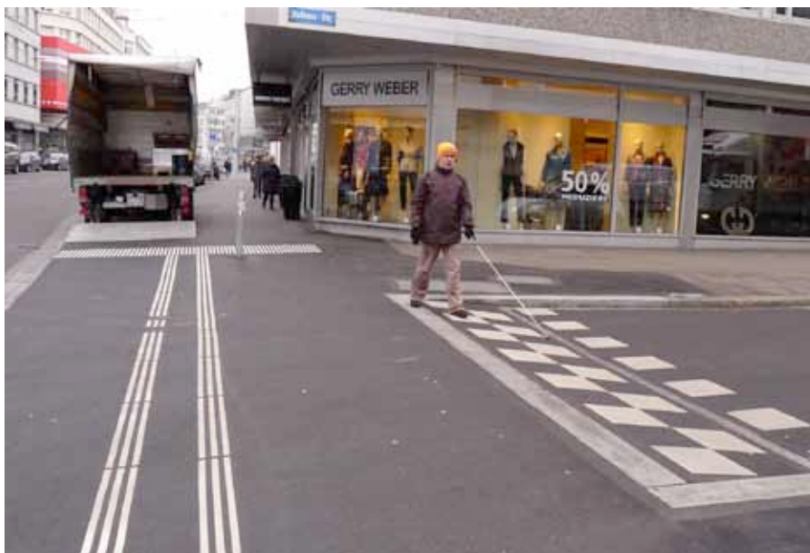
Abgrenzung mit Rampe
