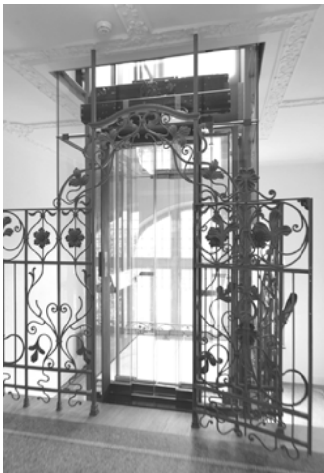
Ascenseur moderne dans l'hôtel historique «Waldhaus Flims Mountain Resort & Spa»
